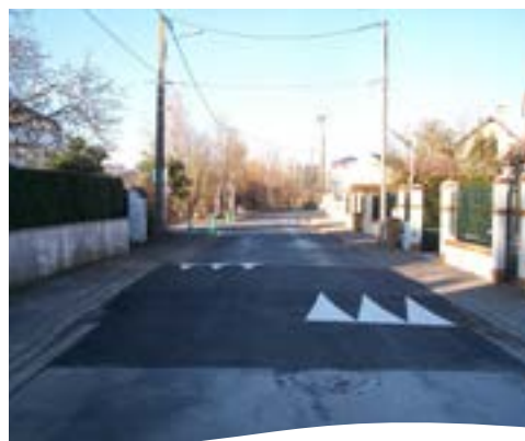
▲ Sécurisation routière à l'angle des rues Champillou et Petit Pont
