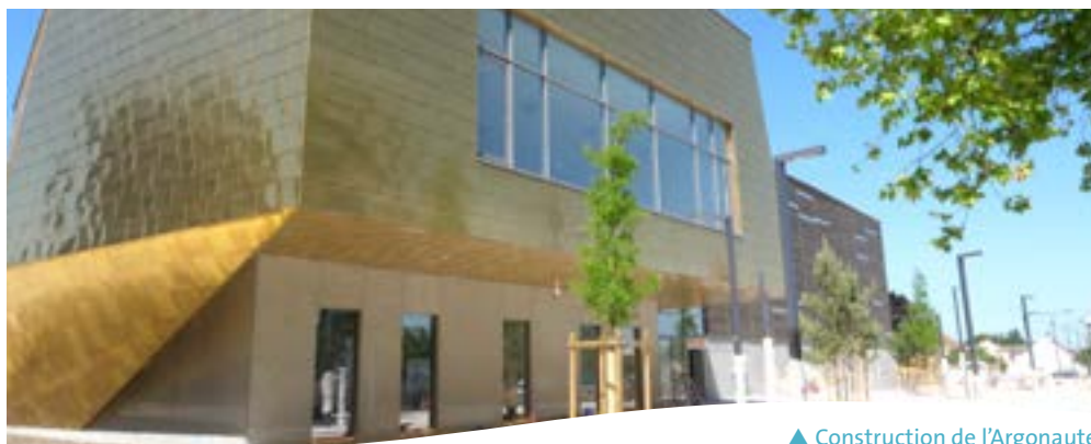
▲ Construction de l'Argonaute
