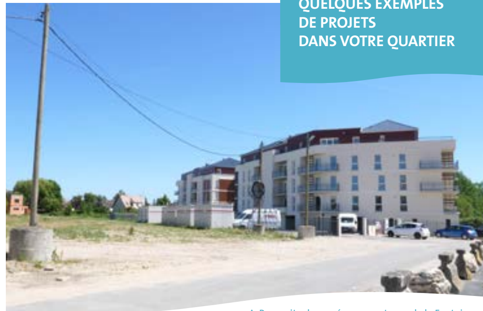
▲ Poursuite des aménagements zac de la Fontaine
