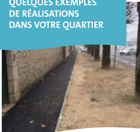
▲ Réfection des trottoirs de la rue Jousselin
